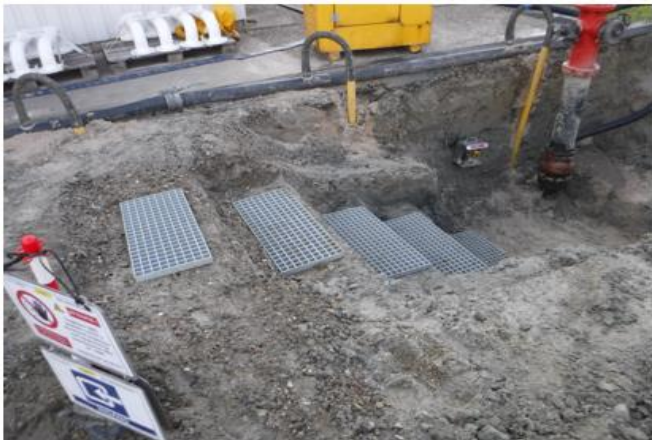
Trapsgewijs gegraven en voorzien van houten verstevigingsplaat.
