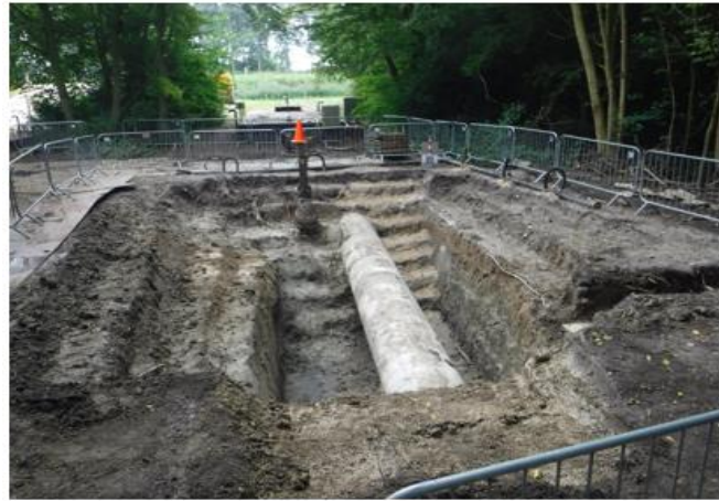
Voorbeelden gegraven sleuf / put: trapsgewijs
