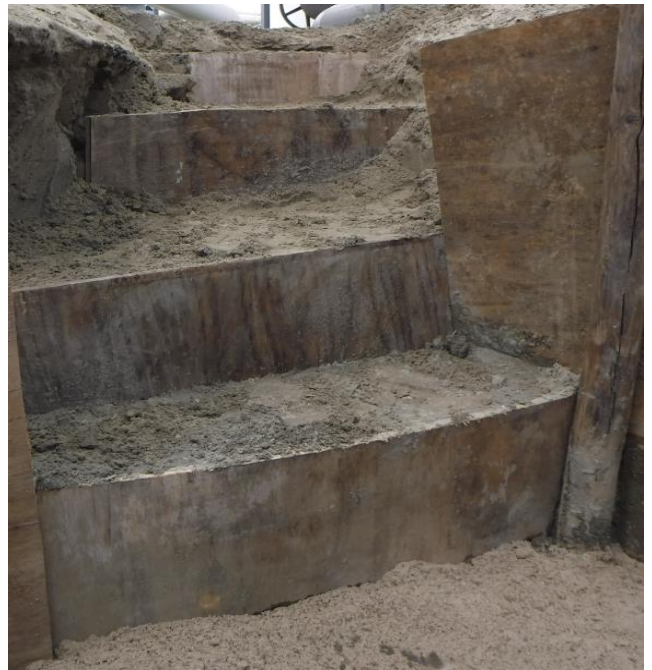
Trapsgewijs gegraven en voorzien van houten verstevigingsplaat.
