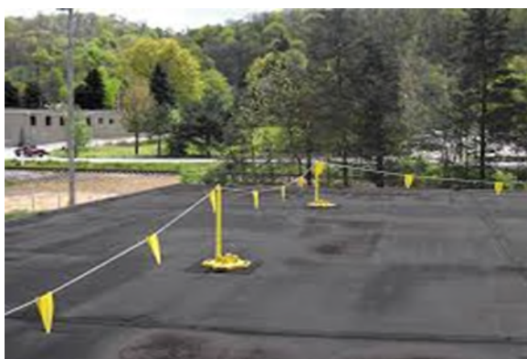
Voorbeelden van waarschuwingsslijnen op een licht hellend dak
