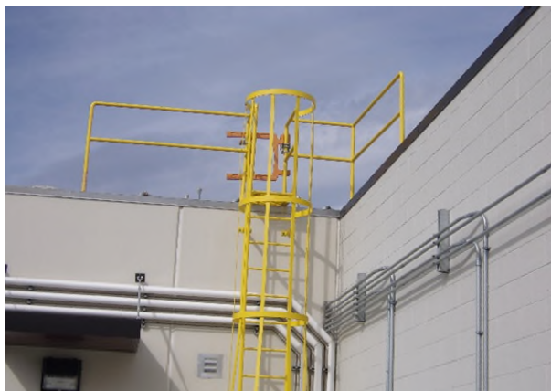
Een voorbeeld van een vaste ladder voor betreding van een dak
